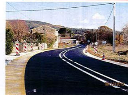
RD980 PR11+141 AVT Après travaux décembre 2013
