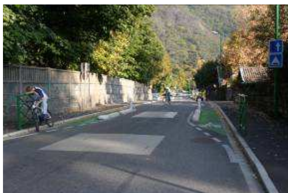
Aménagement de circulation alternée pour les automobiles avec système de ralentissement
